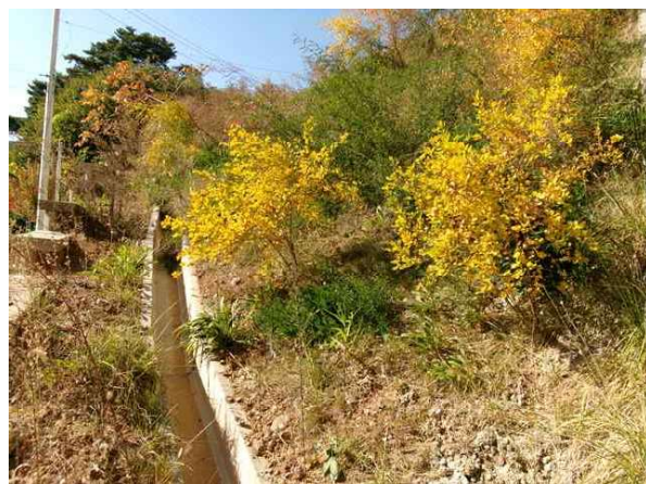
상부 성토부 전경
