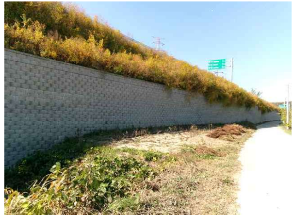
상부 성토부 전경
