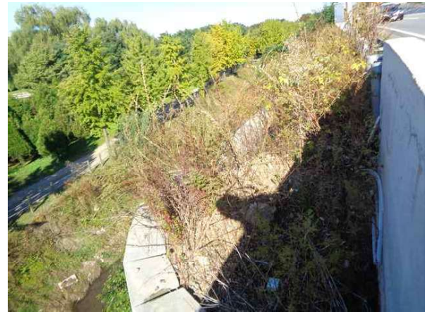
상부 성토부 전경
