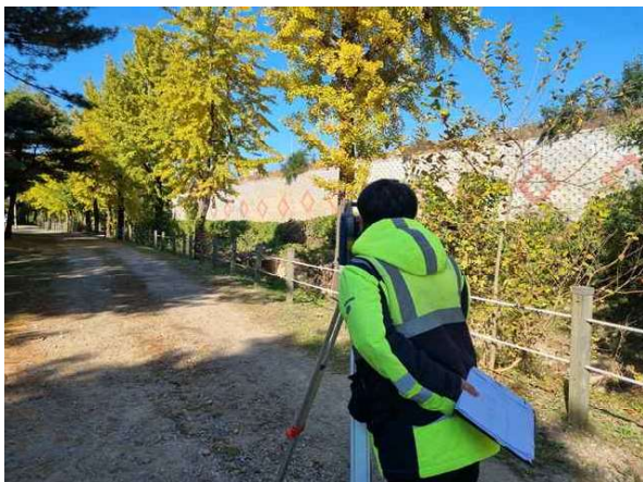
광과기를 이용한 측량 작업
