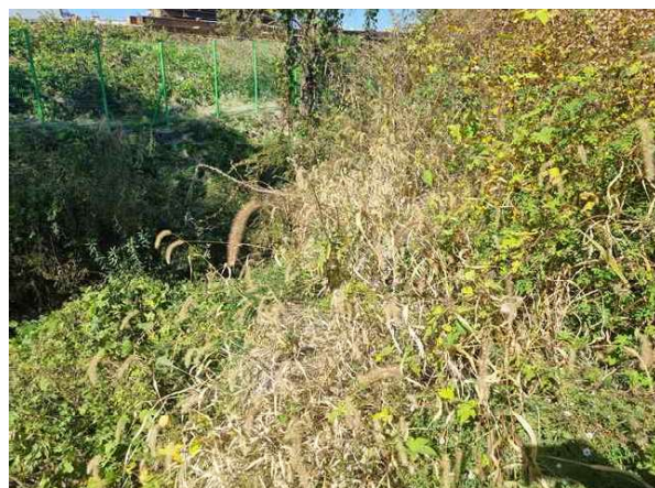
상부 성토부 전경
