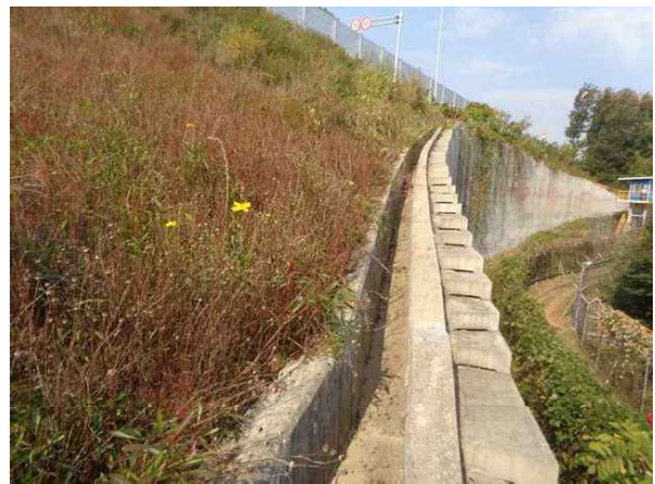
상부 성토부 전경
